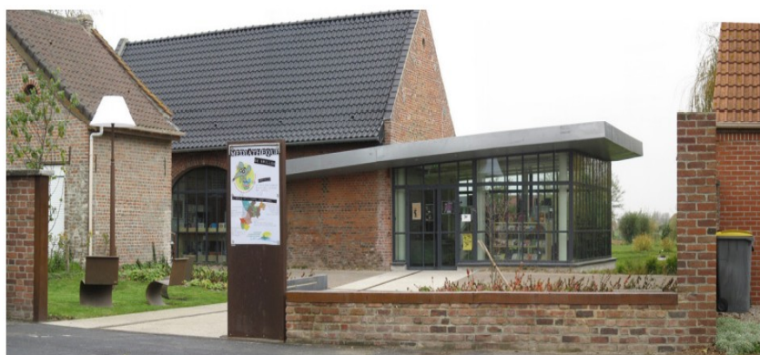
Le mur arasé et la vue ouverte sur l'équipement ...
