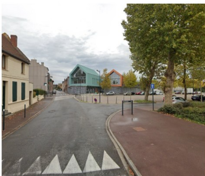
Un équipement en pignon sur rue formant signal ...
